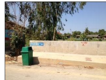
ถ่ายเมื่อวันที่ : - คำอธิบาย : บริเวณที่ซ่อมแซมคันป้องกันน้ำท่วม
