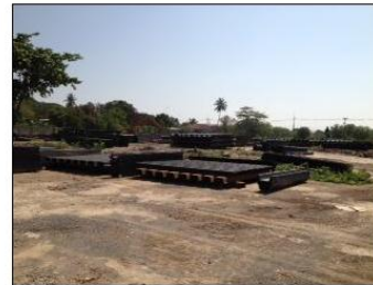
ถ่ายเมื่อวันที่ : 11 พฤษภาคม 2555 09:32:53 น. คำอธิบาย : ปาร์ตเข้าทำงาน(เหล็ก SHEET PILE จำนวน 7,000 แผ่น )จังหวัดสิงห์บุรี
